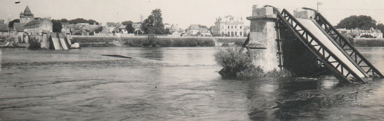
Le pont de Gennes - Les Rosiers-sur-Loire détruit
