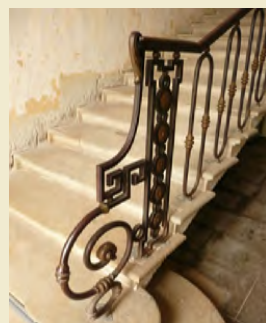
Départ de la rampe d'escalier
