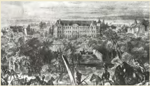
Les bâtiments monastiques vers 1830, après la destruction de l'abbatiale (Gravure de Charles Aubry). De gauche à droite : la petite maison de l'abbé, l'aile nord des bâtiments monastiques construite au début du XVIII e siècle (elle sera détruite avant 1835), l'église St-Barthélémy.
