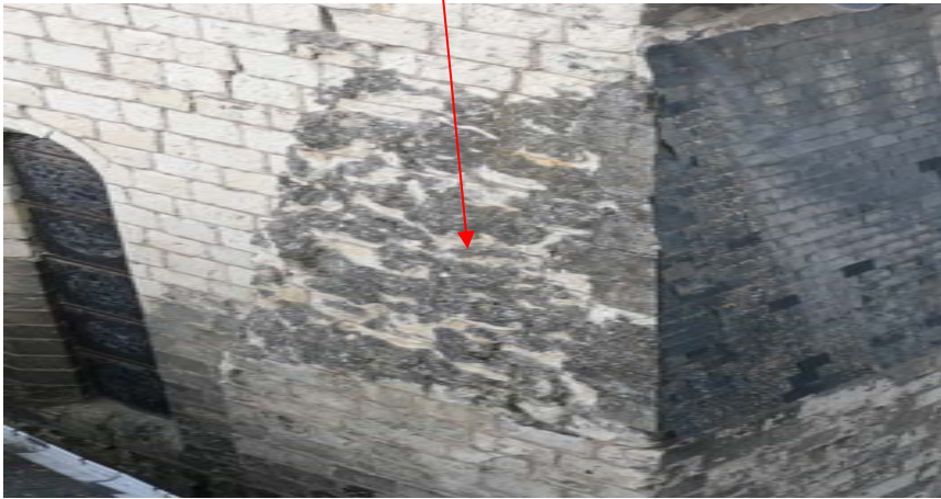
Reprise du contrefort à la chaux
