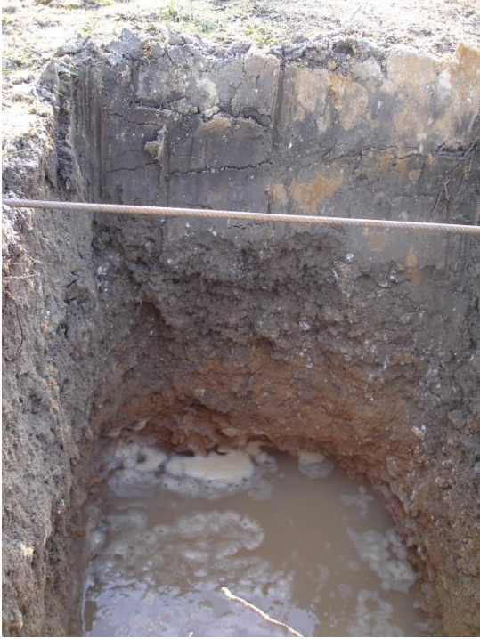
Photo 1 : P1 – Test de perméabilité
