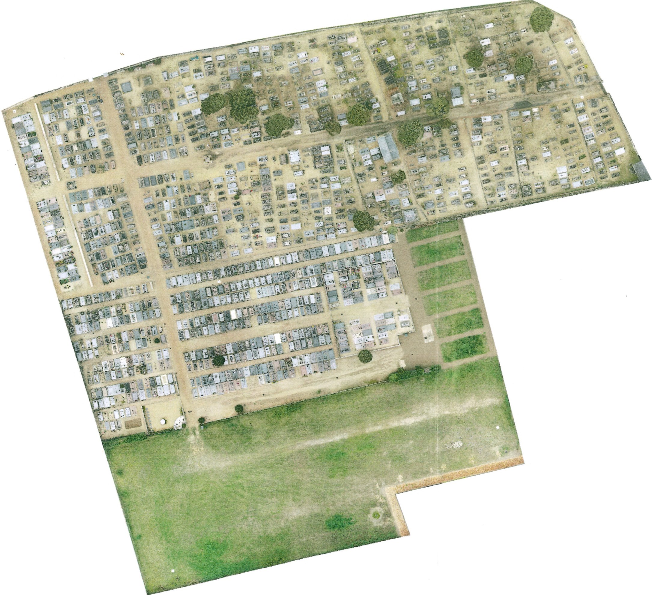
Photo géolocalisée par drone.
