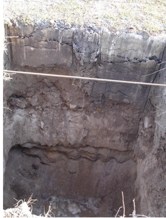
Photo 2 : P2 - Test de perméabilité
