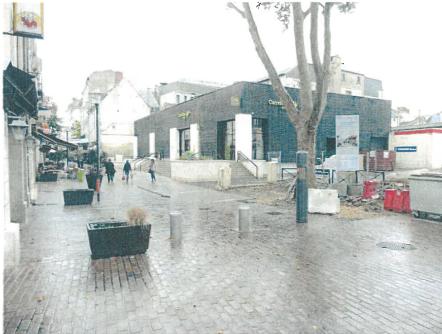
rue St Nicolas après réalisation – bâti requalifié
